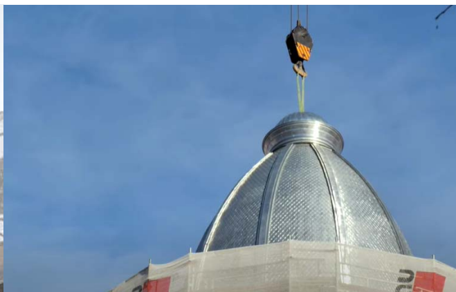
ÁJTK - kupola felhelyezése
