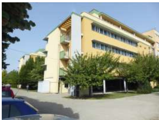
6726 Szeged, Középfasor 52. szám alatti épület a Jobbfasor felől – D-K-i és É-NY-i épületrészek.
