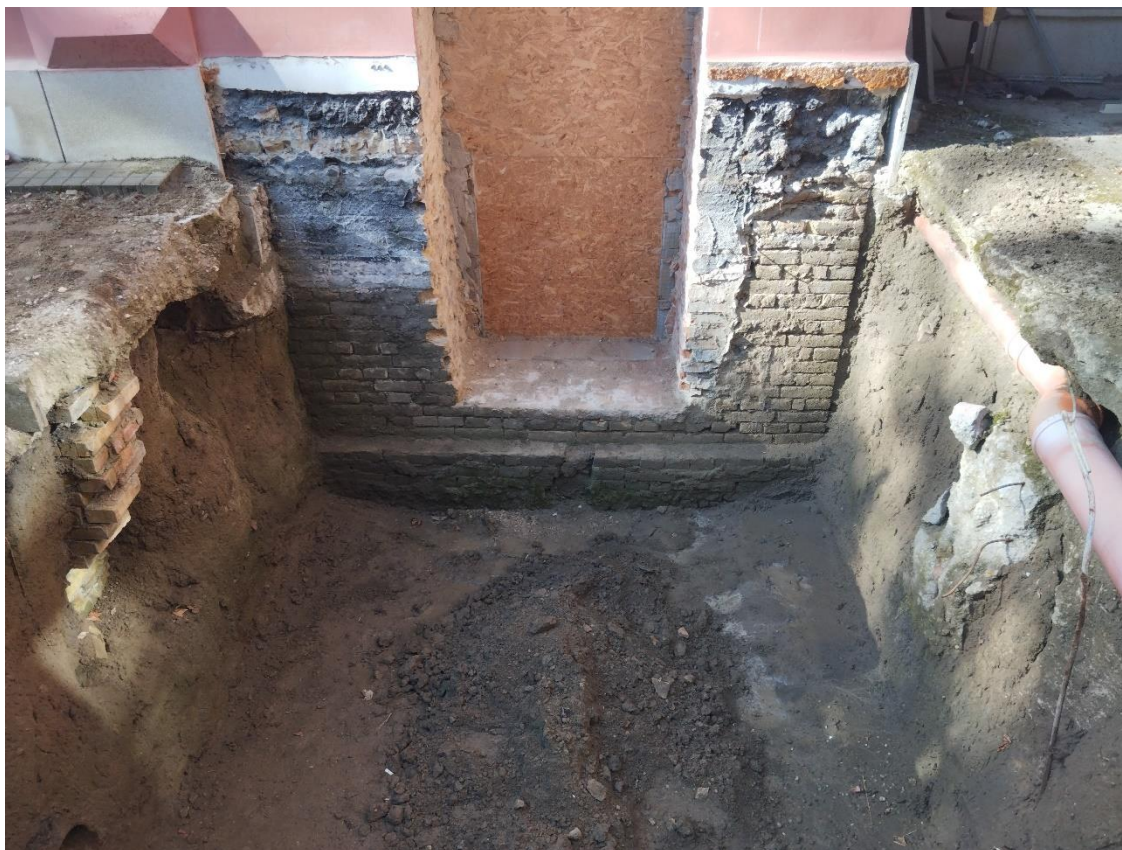
A kiásott liftakna és a Bólyai épület alapozása
