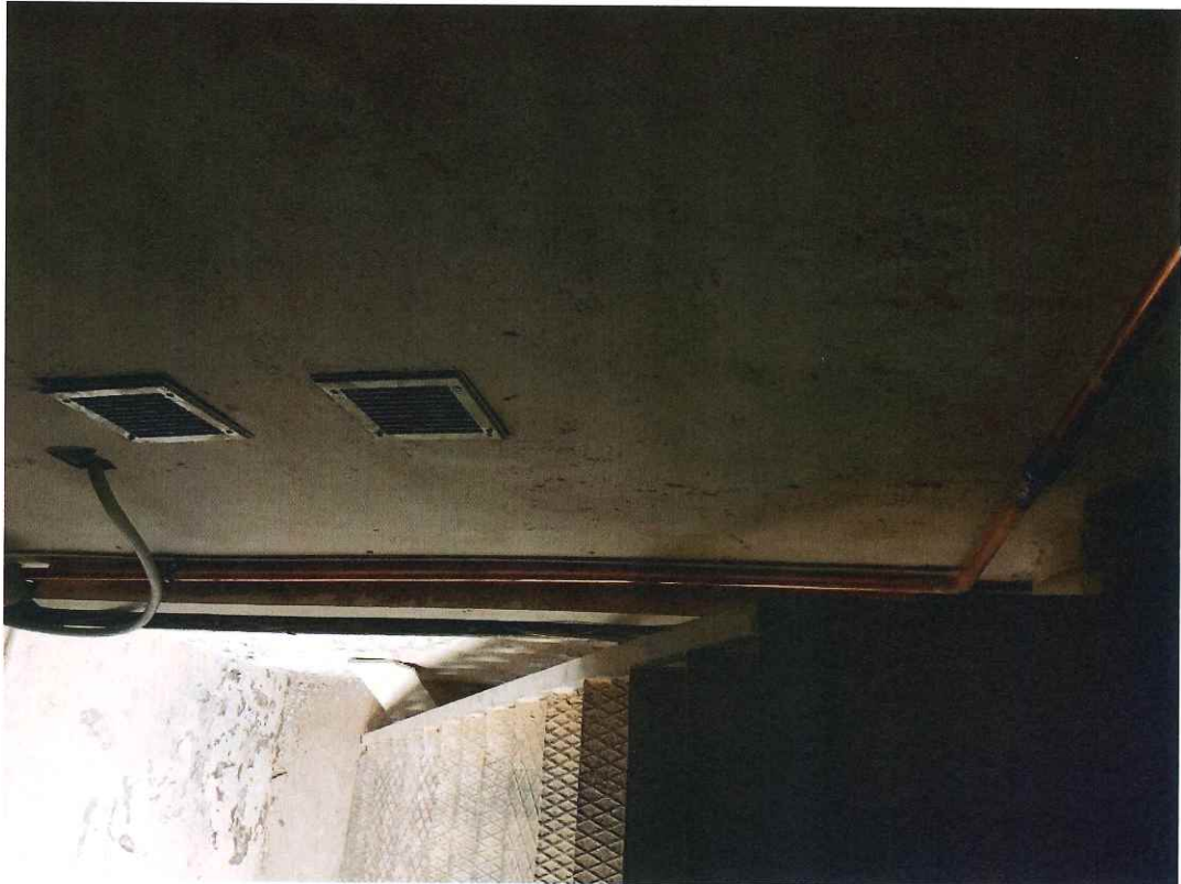
Alacsony-nyomású hélium vezeték és elektromos főkábel
