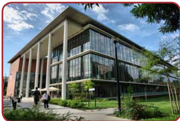
József Attila Tanulmányi és Információs Központ épülete. Attila József Study and Information Centre (TIK).
