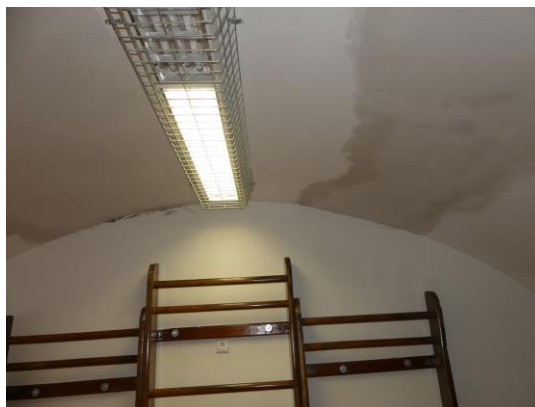
Pincefödém vakoltkárának javítása
